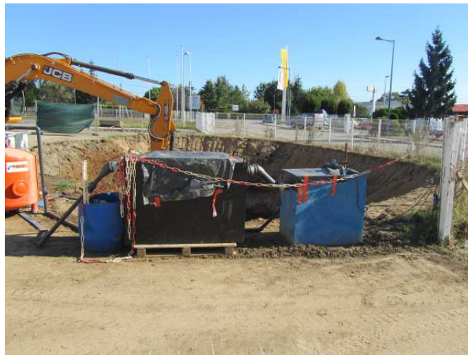
Figure 7 : Vue unité sur traitement des eaux
