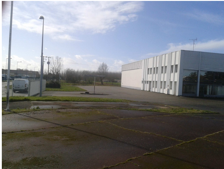
Figure 1 : Vue de la zone à dépolluer
